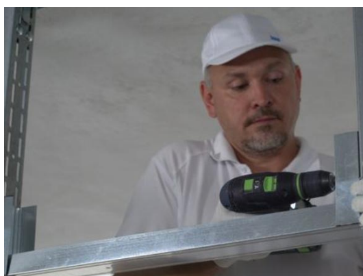
Рисунок 19 – Установка перемычки из направляющего профиля
