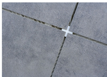
Рисунок 51 - Применение пластиковых крестиков при укладке керамогранита
