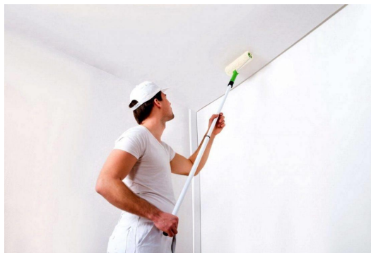
Рисунок 73 – Покраска потолка валиком
