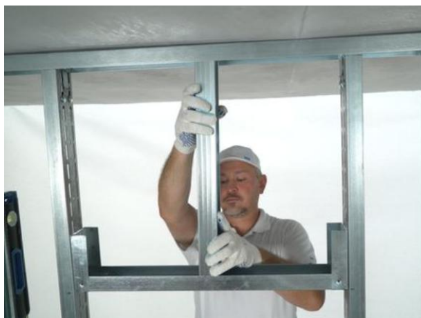
Рисунок 20 – Установка дополнительного профиля
