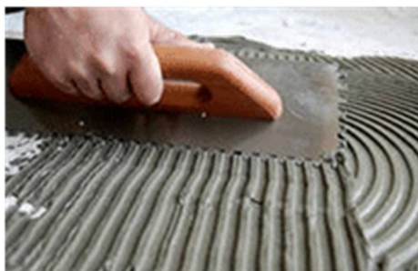
Рисунок 50 - Нанесение на поверхность клеевого состава
