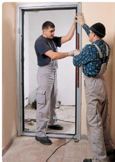
Рисунок 31 – Проверка вертикальности установки дверной коробки
