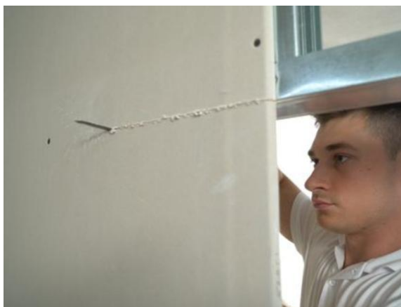
Рисунок 22 – Обрезка КНАУФ-листов
