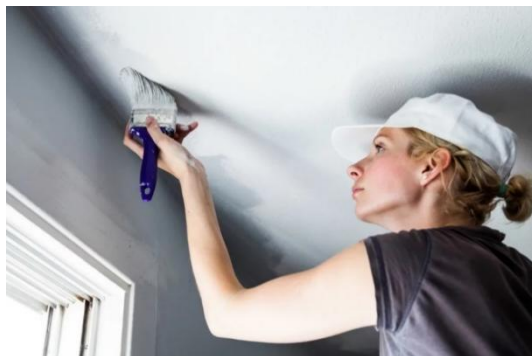
Рисунок 74 – Покраска потолка кистью с подмостей
